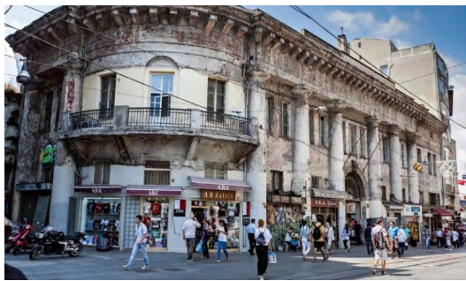
Şekil 12: Restorasyondan önce Narmanlıhan cephesi
