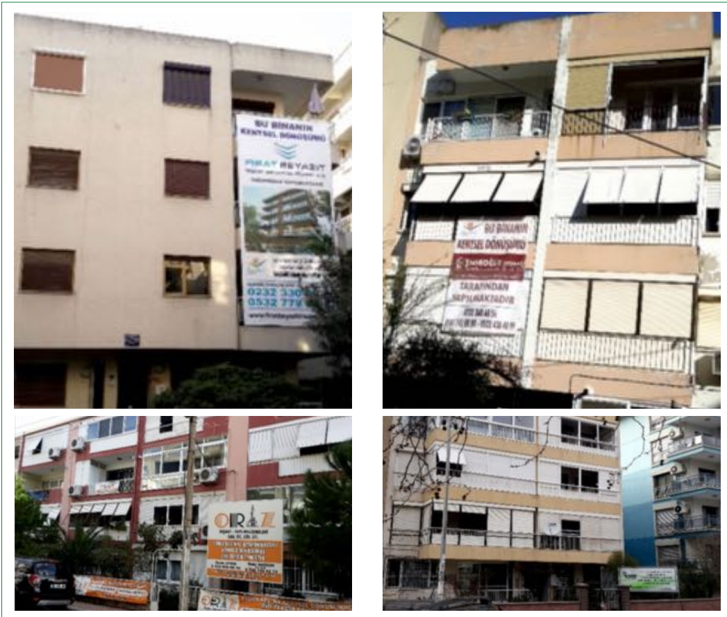
Şekil 4. Anlaşma sağlamış parsellerdeki tabela uygulamaları
