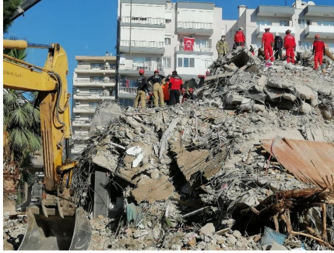
Şekil 3: Sandviç tipi göçen yapılardan bazıları
