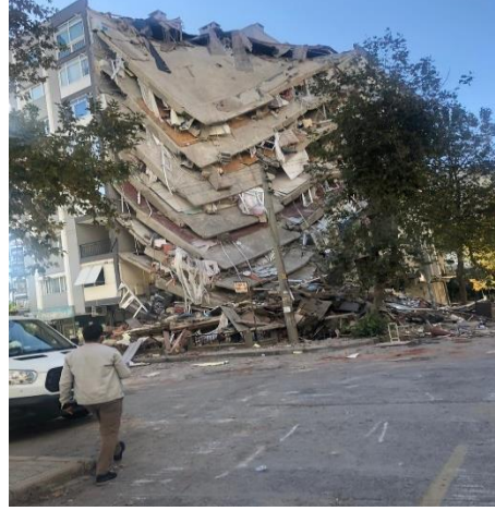
Şekil 5: Planda kısmi göçme görülen bir yapı
