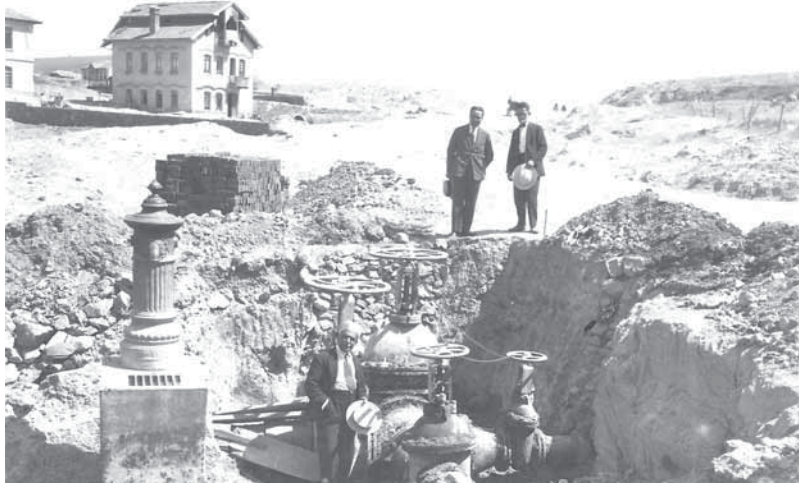
Cebeci su şebekesi yapımı, 1927
