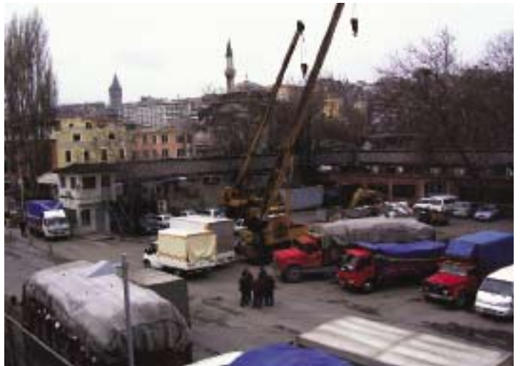
Resim 7: Galataport Projesi çerçevesinde ele alınacak alanın mevcut durumu
