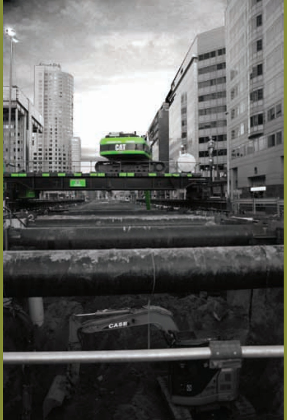
Kenti inşa etmek, Olgu Çalışkan, Rotterdam, 2007
