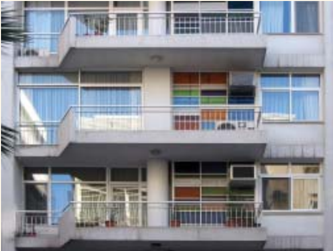
Fotoğraf 1, 2 ve 3. 1930'lu ve 40'lı yıllarda inşa edilen bahçeli kooperatif yapı tipolojilerinde görülen tekli pencere düzeni, Sedat H. Eldem'in belirlediği 1950'lerin II. Ulusal söylemi doğrultusunda sürekli yatay pencere kurgusuna dönüşmüş, 1960'ların başında ise tümüyle şeffaflaşarak bütün cepheyi tanımlar hale gelmiştir.
