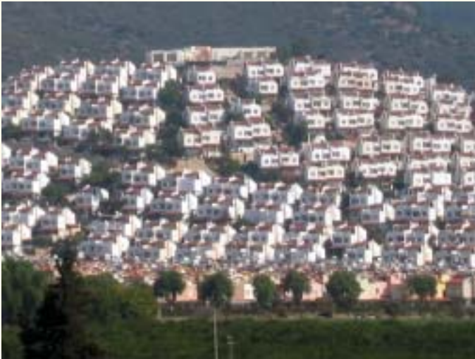
Fotoğraf 13. Tüm kıyı alanlarında yaşanan ve Gümlüder-Özdere bölgesindeki tarım alanlarını da hızla dönüştüren kontrolsüz ve niteliksiz ikincil konut uygulamaları.
