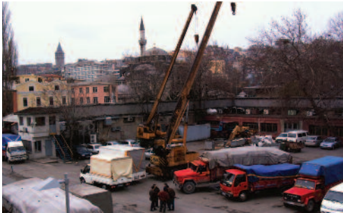
Resim 7: Galataport Projesi çerçevesinde ele alınacak alanın mevcut durumu
