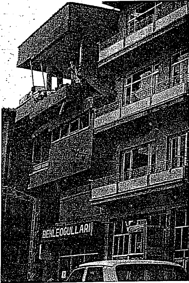
Dinar'da bilmiş düzen, çıkmalı, asimetrik tasarımı ve sonradan kat ilave edilmiş bir yapının depremle aldığı görüntü.
