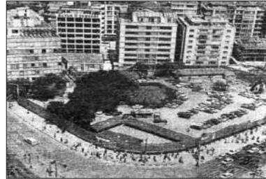
Kızılay Binası Yıkımı Sonrası (Kaynak: Batuman, 2000)
