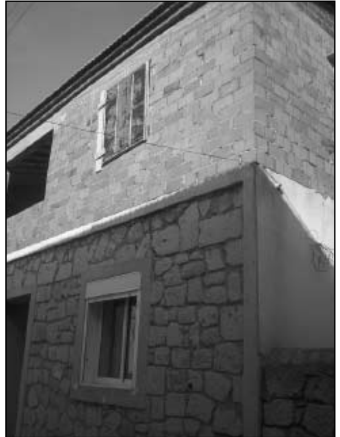
Şekil 15. Taş kaplamalı betonarme bina örneği
