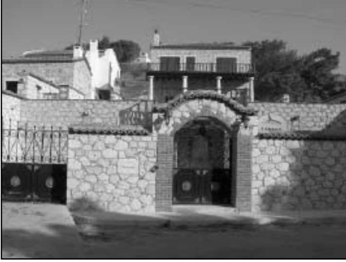
Şekil 16. Yeni yapıda bahçe duvarı ve kapı örneği
