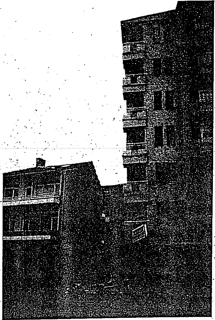
Üç büyük kentte, kent merkezlerinde yoğunlukların artınması biçimindeki gelişme modeli tüm Türkiye kentleri için geçerli bir gelişme modeli haline gelmiştir. Gölcük'te, depremden az hasarlı olarak kurtulabilmiş olan çok kalı bir yapı ile imar planında öngörülüş olan imar hakkını deprem öncesinde kullanma fırsatını yakalayamamış olan az kalı bir yapı. (Ç. Keskinok kişisel belgeliği)
