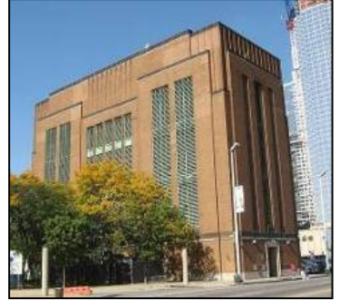
Şekil 13. New York kentindeki bir karayolu tüneline ait havalandırma bacası
