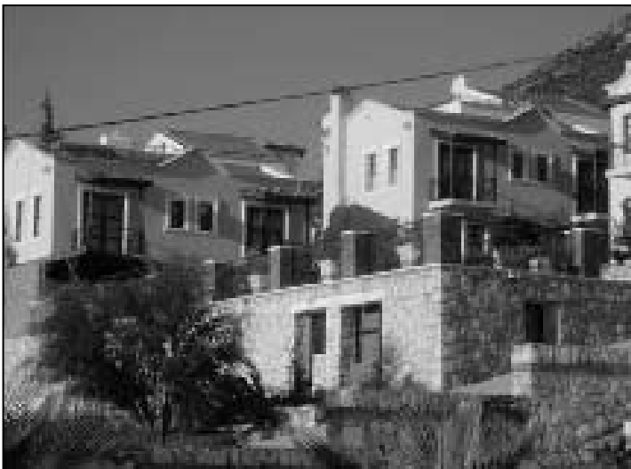
Resim 2a, b: Kalkan'da yeni inşa edilen villalar (Kasım, 2004).
