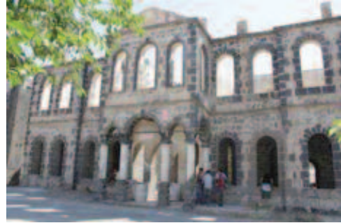
Şekil 8. Kolordu Binası (ANONİM, 2010a)
