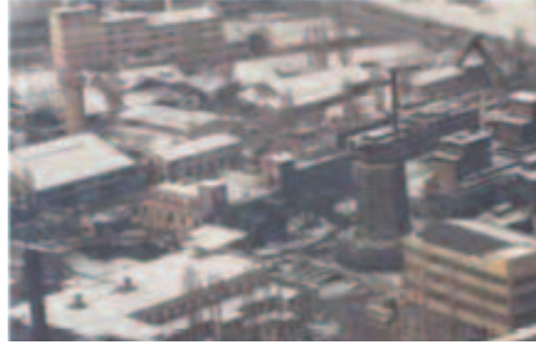
Fotoğraf 2: Bulvarın İnşaatında Sonra Maltepe Havagazı Fabrikası
