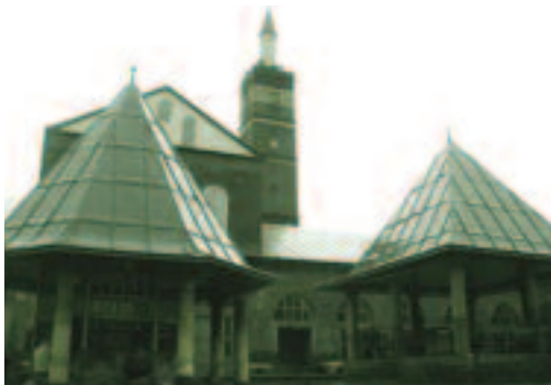
Diyarbakır Ulu Camii
