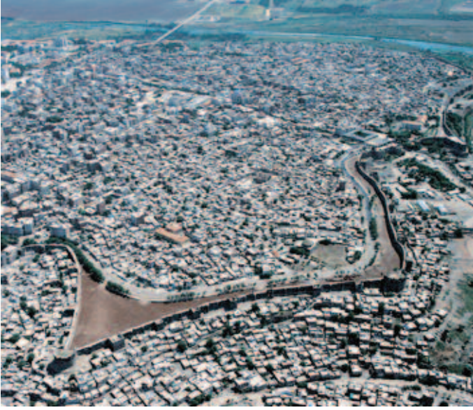
Şekil 1: Diyarbakır Surları Üstten Görünüşü
