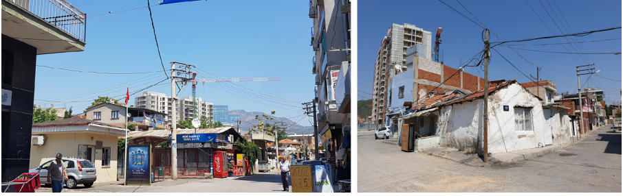
Şekil 5: Örnekköy Kentsel Dönüşüm Proje Alanı ve 1. Etap İnşaatı
