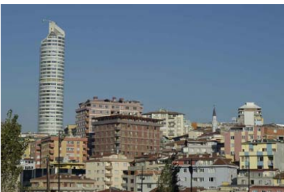
Resim1. Konut Alanlarında Zıtlık, Çarpıklık ve Dik Mahalle Anlayışı
