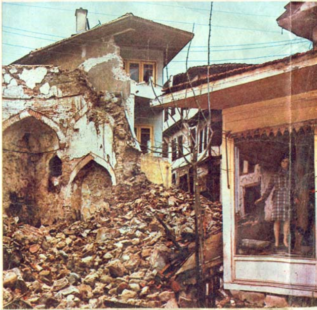
Depremde büyük hasar göre Gazanfer Ağa Hamamı, (Hayat Mecmuası, Nisan 1970)
