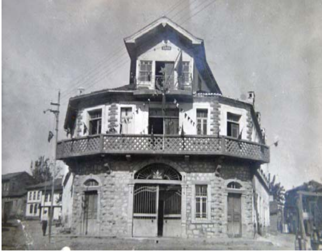
Resim 51. Eski Tekel Binası ( http://www.flickr.com/photos/bigam4/4987177384 )
