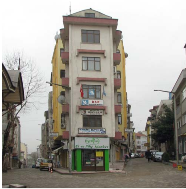
Resim 39. Biga planından kaynaklanan köşe yapı
