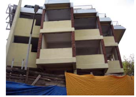
Resim 86. Sanyorum Vakıflar Bankasına ait olan bu yapının, iyi bir modern mimarlık uygulaması olmasına karşın yıkılmasını benimseyemiyorum.
