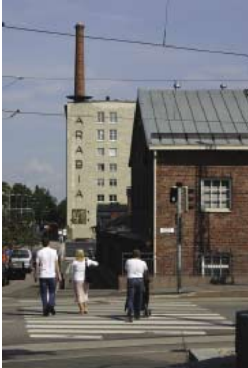
Resim 2: Arabianranta, Arabia Porselen Fabrikası’nın eski binaları (Kaynak: kişisel belgelem, 2005)
