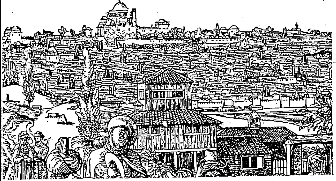
Şekil 4: 1509 depreminin sonradan Fatih Caminin gördüğü hasarı gösteren Peter Coecke tarafından yapılan bir minyatür (c. 1529). 16. yy. itibarında Coecke'nin minyatüründeki yıkılan minareleri dikkate alarak Wulzinger tarafından çizilen Fatih Caminin depremden önceki hali.
