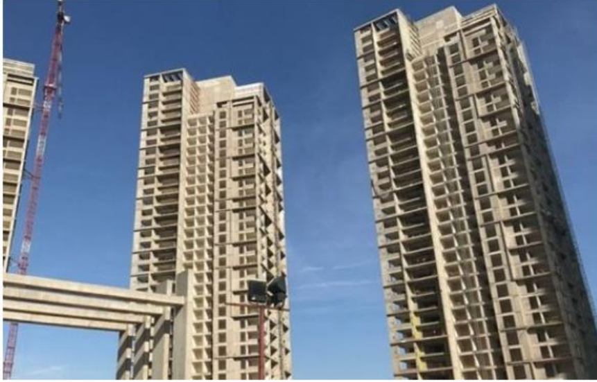
35 katlı rezidans inşaatı iptal kararına rağmen devam ediyor!
