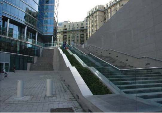
Foto 14: Avrupa Komisyonu Berlaymont Binası Girişi; Çırak, 2007
