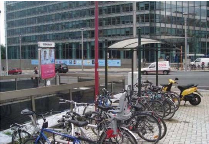
Foto 5: Ru De La Loi ve ofis yapıları, Steenwegen,2007
