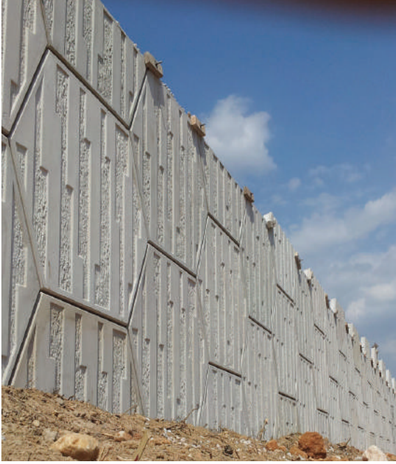
Bölgede halen şev/duvar olarak imalatı yapılan uygulamalardan örnek
