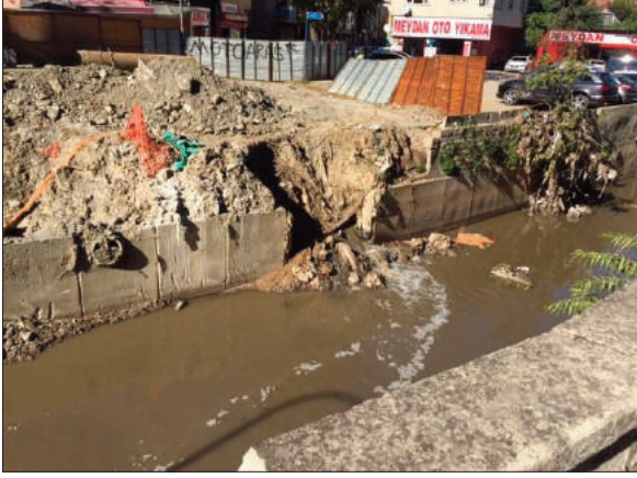
Şekil 13. Kadıköy Belediyesi'nin Karşısında Açığtan Akan Sıvı Atıklar; Kurbağalıdere
