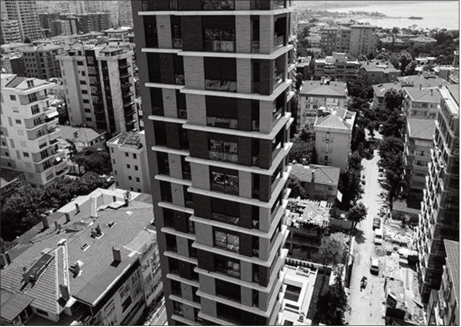
Şekil 6. Bağdat Caddesi Çevresinde İnşa Edilmiş 17 Katlı Bir Konut Örneği Denge İnşaat, http://dengeinsaat.com/Projeler/denge-vapur yolu-13/
