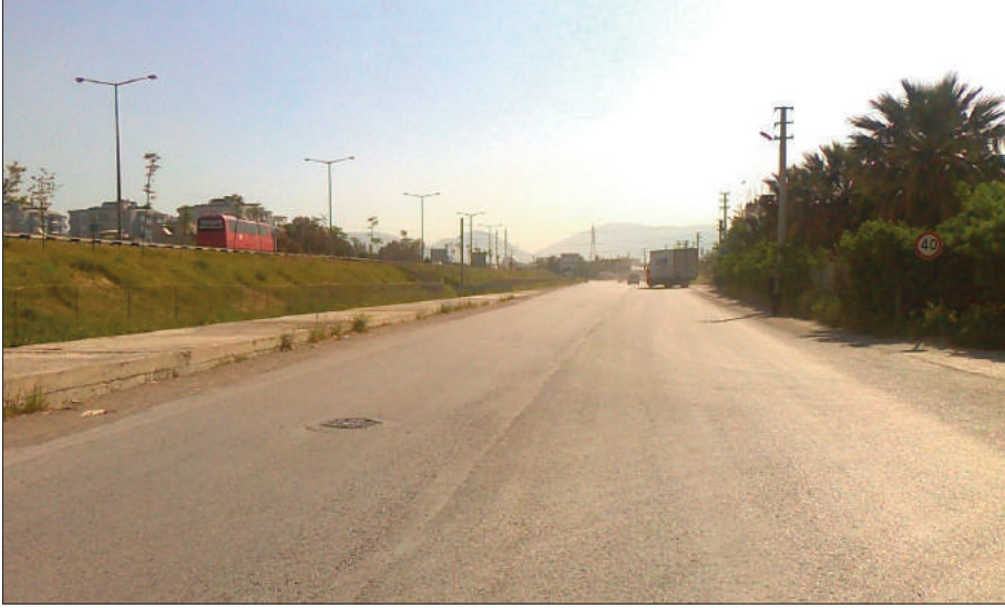
Bornova Doğanlar mahallesinde Proje bağlamında Kapanan caddelerden birisi (1550/2)
