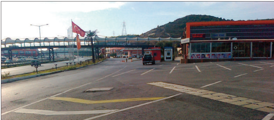
Kamu Özel Sektör Ortaklığında rant alanına dönüştürülen akaryakıt ve dinlenme tesisi bağlamındaki kötü örnek
