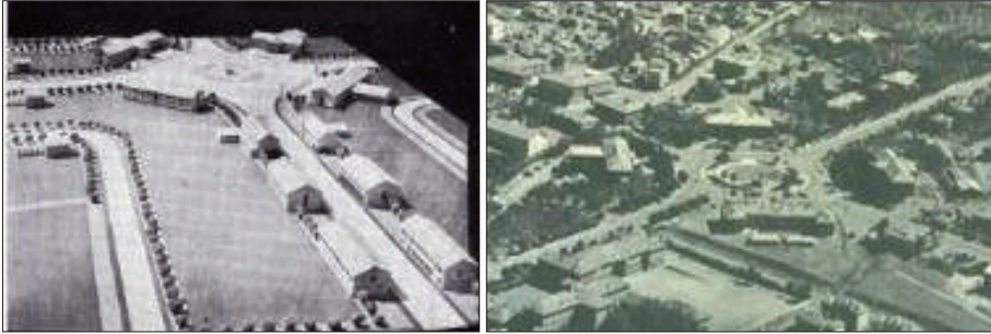
Fotoğraf 1. Cumhuriyet Meydanı: Cumhuriyet Caddesi tarafından maket görüntüsüne bakış (Belediye Dergisi, 1939; aktaran Karakaya, 2010) (solda), 1960'larda Cumhuriyet Meydanı (Hatıralarla Erzurum, 2011) (sağda).
