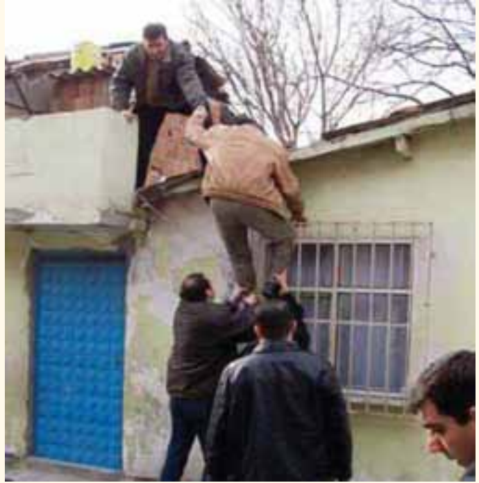
Sulukule Yıkımları http://emlak.mynet.com/ 20 Ağustos 2006
