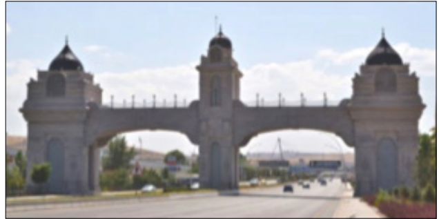
Esenboğa Yolu Kent Giriş Kapısı
