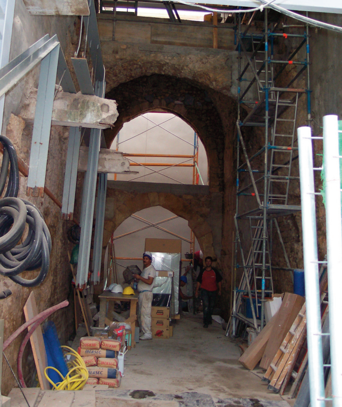
Şekil 11: Belediye Meydanı'ndaki banka binası inşaatı ve forum kalıntıları, Tarragona, 2004 (kişisel belgelem)
