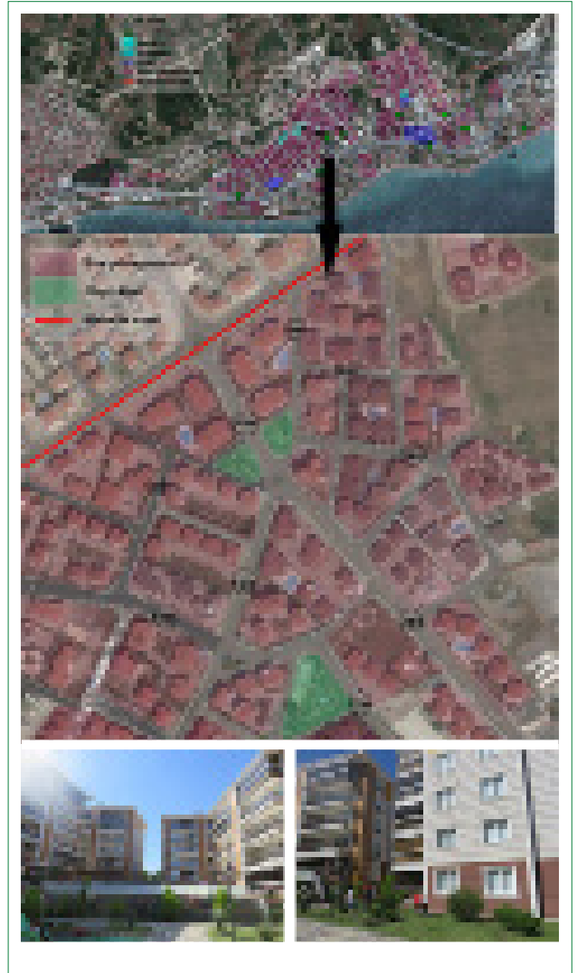
Şekil 2. Hürriyet Mahallesi'nde kapalı site yerleşimleri*.
