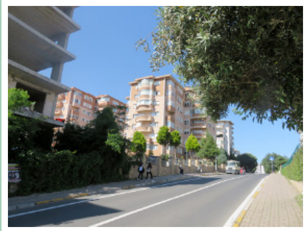
Şekil 5. Hürriyet Mahallesi, Şehit Rüştü Ökeler Caddesi'nden görünüm.
