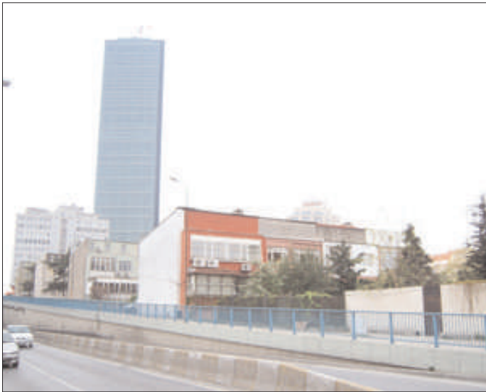
Fotoğraf 11: Levent Mahalleleriyle 4. Levent'i birbirinden ayıran taşıt alt geçiti ve Büyükdere Caddesi üzerinde üzerindeki 3 emsal yapılaşma sonucu ortaya çıkan konut bloğu.
