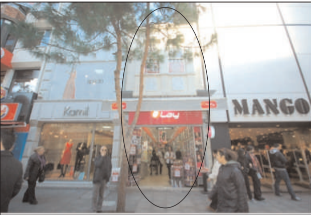
Resim 24. 60 ada, 9 parsel ve bitişikteki yapıların görünümü
