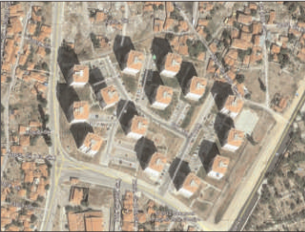
Fotoğraf 3. Gültepe Mahallesi 1. Etap Yeni Konut Hava Fotoğrafi (Googleearth hava fotoğrafı, erişim tarihi 28.09.2012)
