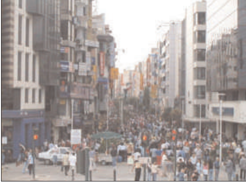
Resim 25. 1717 Sokak'ta Giydirme Cepheli, çok katlı yapılaşma
