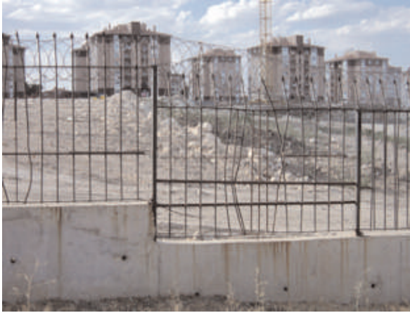
Fotoğraf 7. Site duvarları
