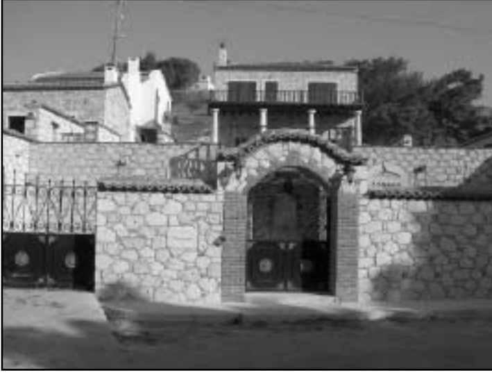
Şekil 16. Yeni yapıda bahçe duvarı ve kapı örneği
