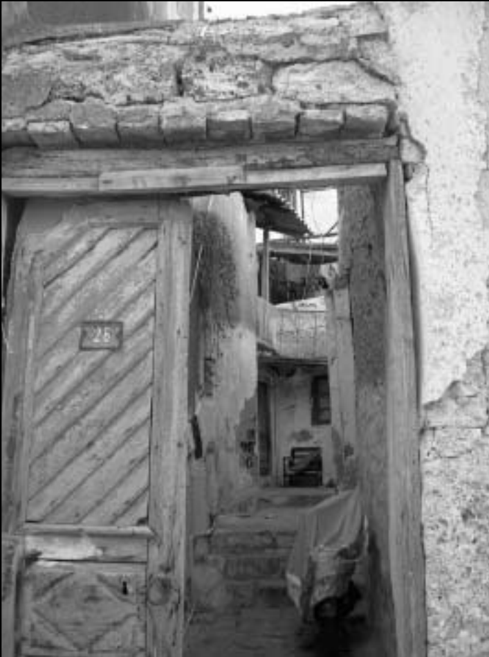
Şekil 3. Eski yapıda kapı örneği
