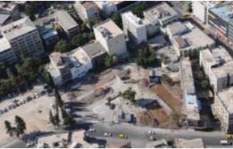
Şekil 22: Yıkım Çalışmalarında Sobacılar Çarşısı, Kaynak: Antalya Büyükşehir Belediyesi Arşivi
