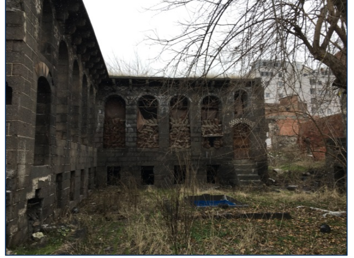
Foto 4: 385 ada 14 nolu parsel tescilli yapı mevcut durumu
