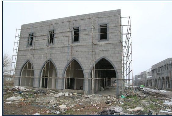
Foto 20 Yeni yapılan yapıların cepheleri
