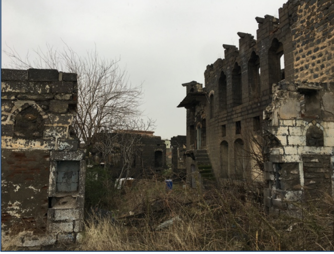
Foto 3: 30 ada 2-3 nolu parsel tescilli yapı mevcut durumu
