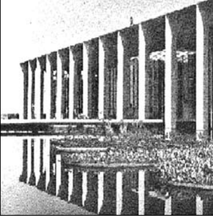
Şekil. 3. Çağdaş mimarinin elemanı olarak betonun cephede kullanımıyla yaratılan etkiye Brasilia'dan bir örnek: Itamarity Sarayı (Evenson; 1973:207).
