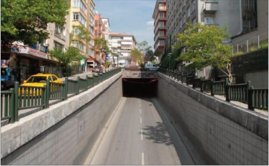
Şekil 2: Ankara’da Akay Caddesi üzerindeki katlı kavşak: Yol boyunca yer alan kullanımlara erişim sağlama işlevi için tasarlanmış bir yolun araç akımı sağlama işlevine dönüştürülmesi (Fotoğraf internette alınmıştır)
