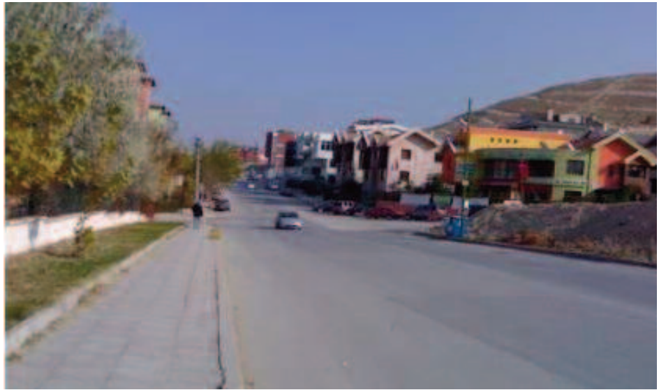
Şekil 12-13: Ankara'da konut alanları içindeki yerel yollar: Kademelenme yaklaşımına aykırı, aşırı geniş, dolayısıyla yüksek hızda olanak veren altyapılar (Fotoğraflar internetten alınmıştır)
