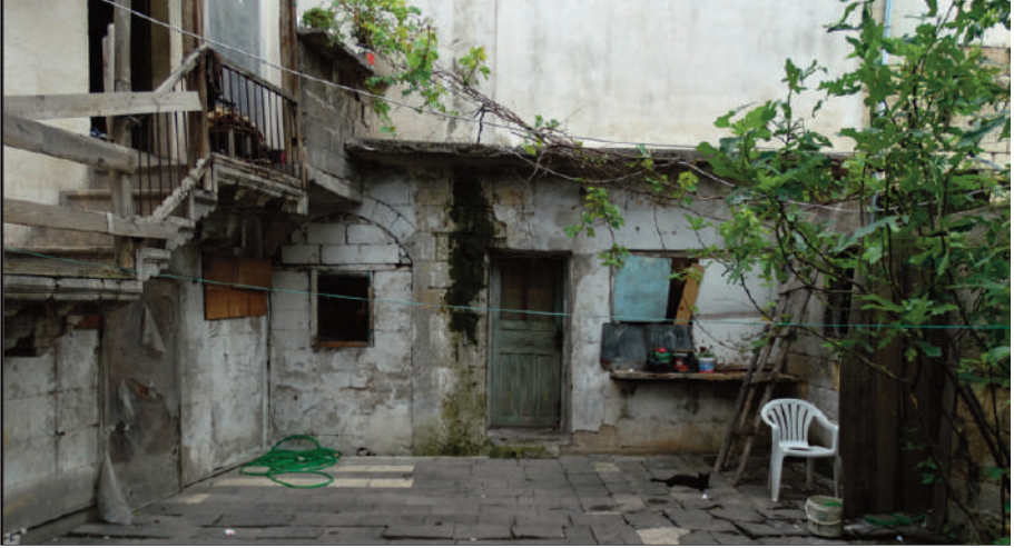
Şekil 11: Süreç içinde yapılan ilave yapılar.
