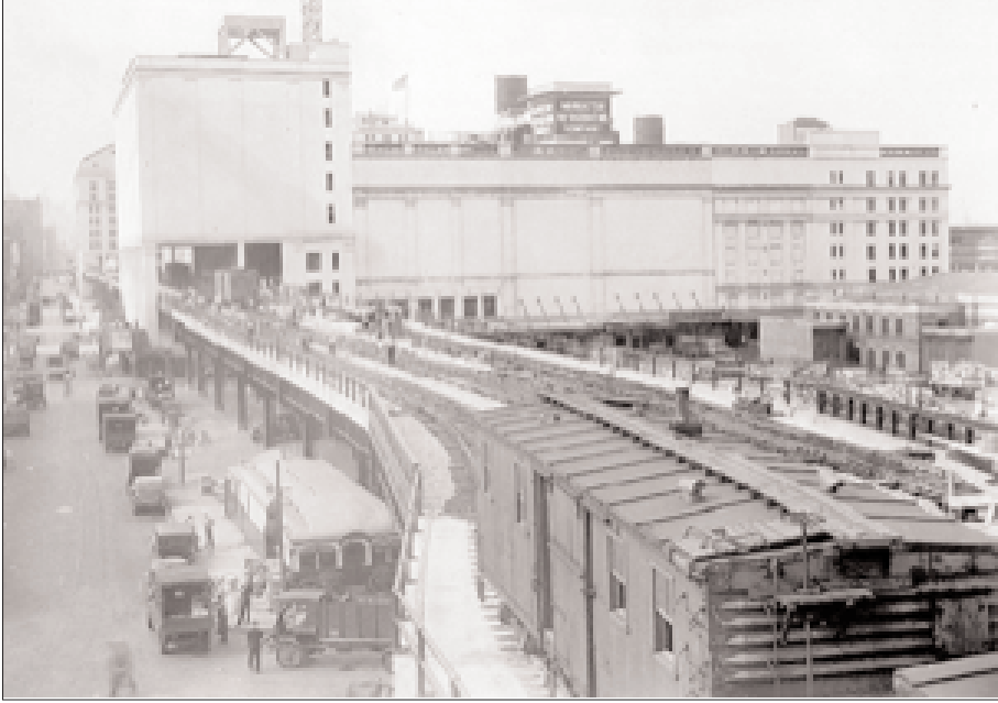
Resim 3. Batı Yakası İyileştirme Projesi kapsamında yol üstüne taşınarak yükseltilen tren hattı (5).
