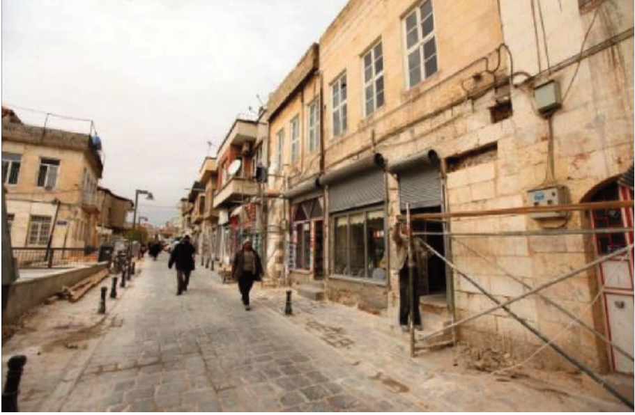
Şekil 14: Sokak sağlıklılaştırma projesi uygulamaları
