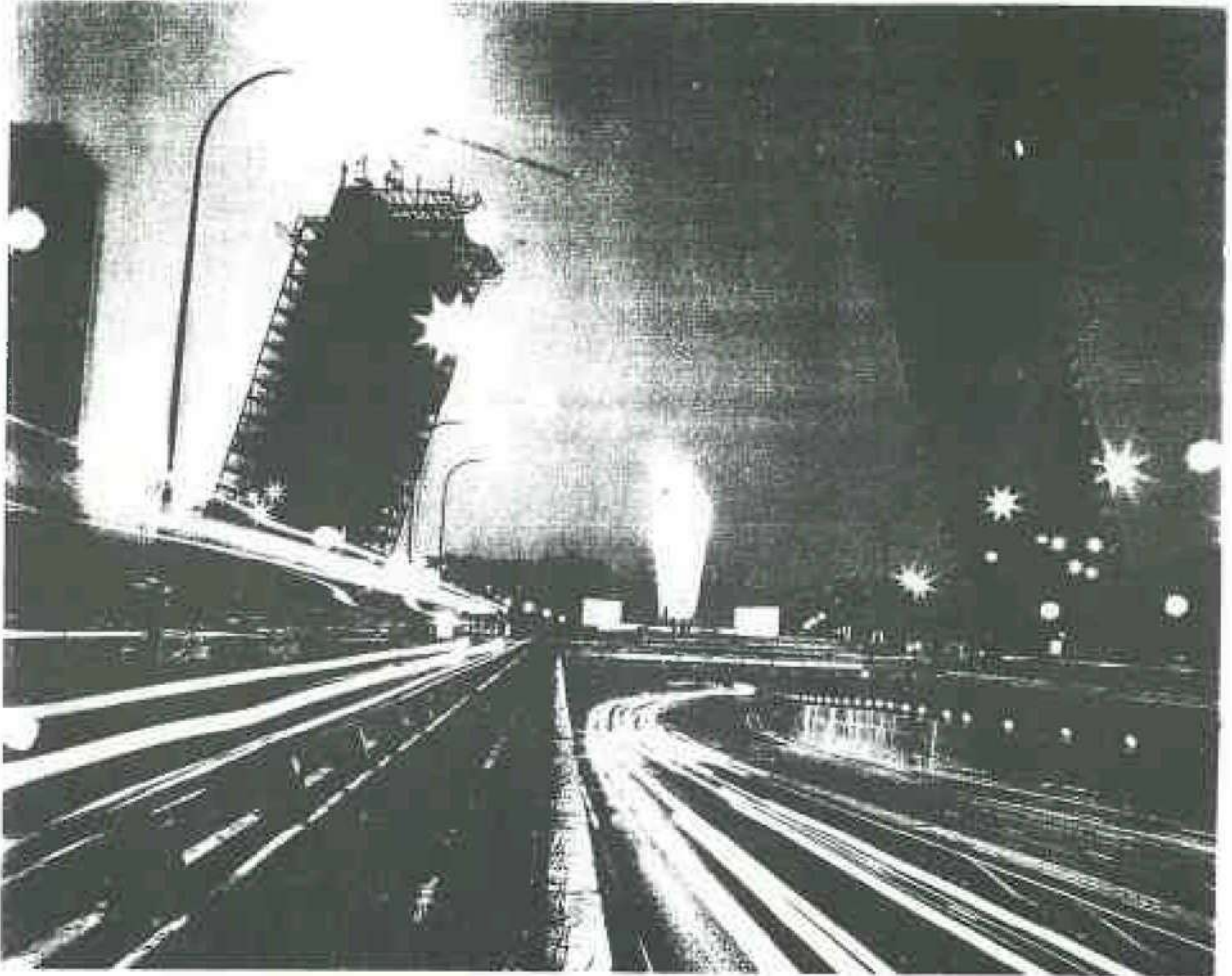
Remodelación de la Plaza de Castilla
