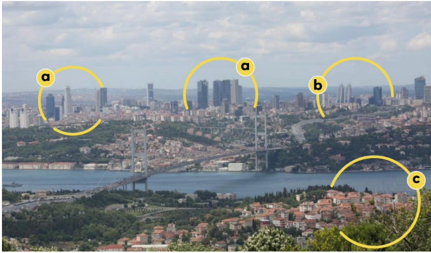
Şekil 3. 17 Fatih Sultan Mehmet Köprüsü ve Boğaziçi (Kozaman, 2007)
