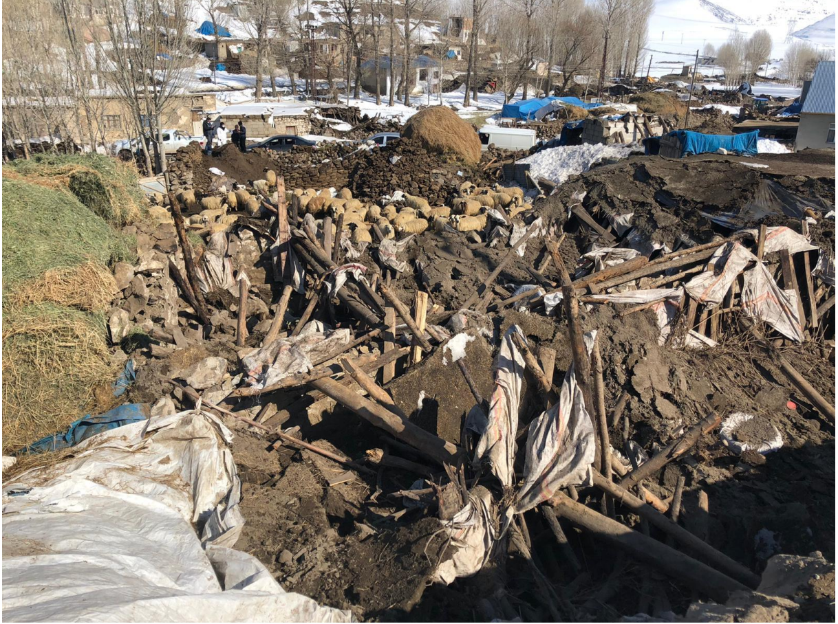
Şekil 21 -Hayvancılık yapan yöre halkının deprem sonrası ahırlarının durumu
