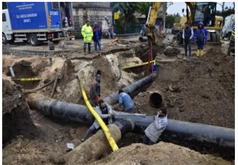
Urfa Kapı'nın tam önünde, altyapı için açılan derin ve geniş kazı alanı
