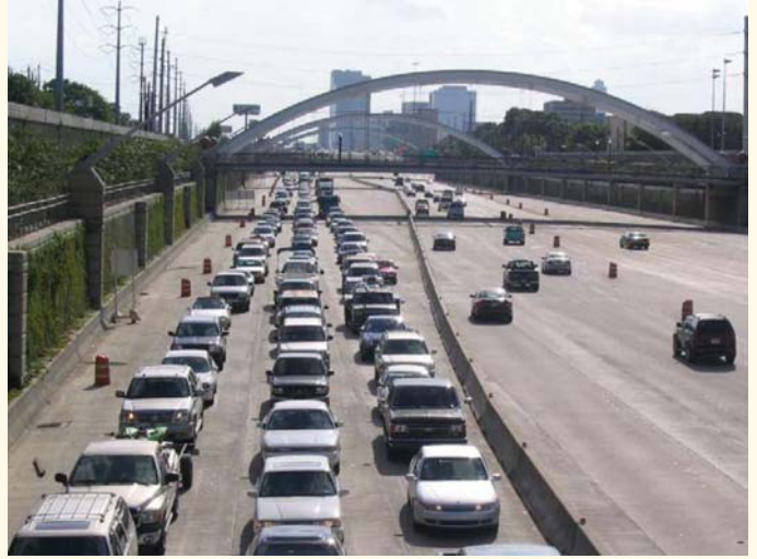
Fotoğraf 2. Kenti kuzey-güney doğrultusunda kesen 59 nolu otobanda genişletme çalışmaları.
