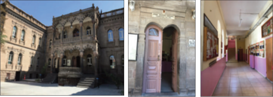
Resim 12, 13, 14 Develi Lisesi Cephe, giriş kapısı ve iç mekanı (Ö. Kevseroğlu, 06.09.2017)
