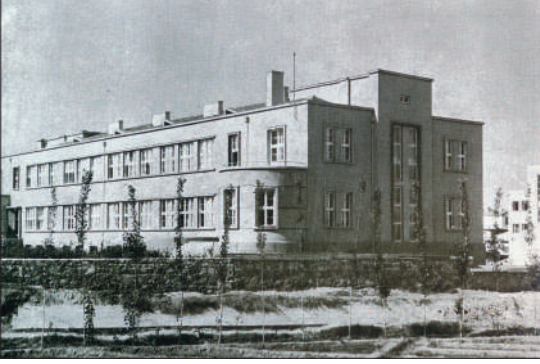
Şekil 4. 1937’de yapılan ilk yapı
