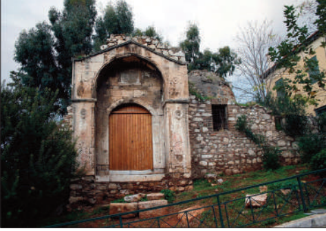
Şekil 9 Cümle kapısı hariç yıkılıp harabe olarak bırakılan Medrese, Atina
