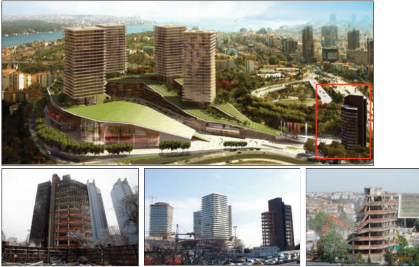
Fotoğraflar: Üst; TC Karayolları 17. Bölge Genel Müdürlüğü yapısı ile Zorlu Center ilişkisi (URL1), Alt; Yapının yıkımı ve rekonstrüksiyonu süreci (URL1)
