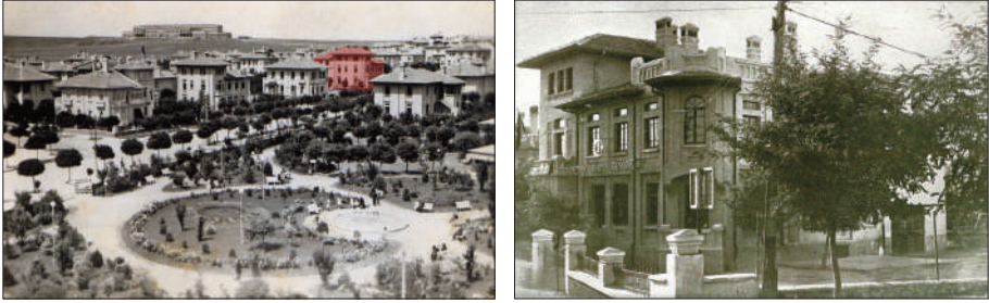
Şekil 1. Yenişehir’de kurulan Ana Mektebi Binası
