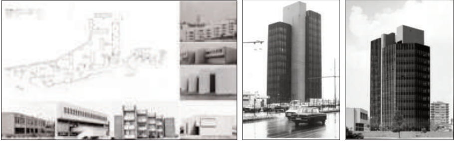
Fotoğraflar: Sol; Karayolları 17. Bölge Müdürlüğü Kompleksi yerleşim planı (Batur, 2012: 38-57), Orta ve Sağ; Farklı açılardan Genel Müdürlük Binası (Mehmet Konuralp Arşivi)
