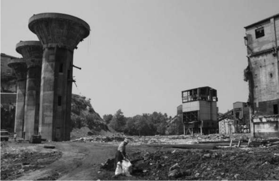
Şekil 4 yıkım sırasında lavuar
