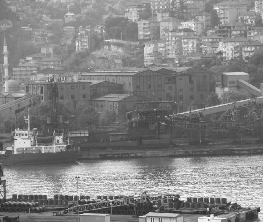
Şekil 1 yıkım öncesi lavuar
