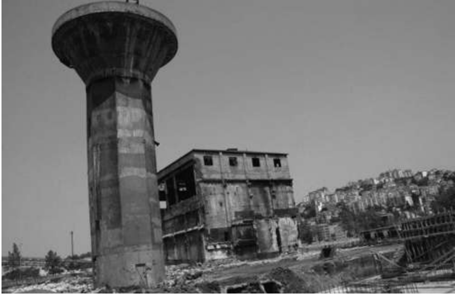
Şekil 6 yıkım sırasında lavuar
