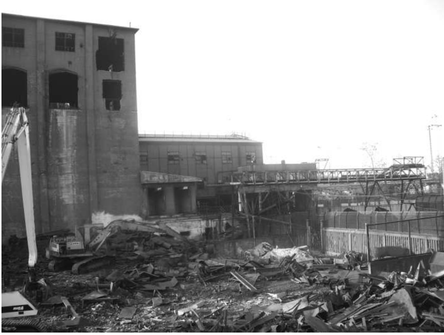
Şekil 5 yıkım sırasında lavuar
