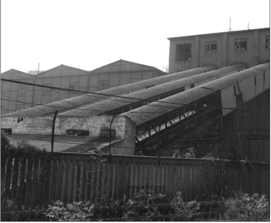
Şekil 2 yıkım öncesi lavuar
