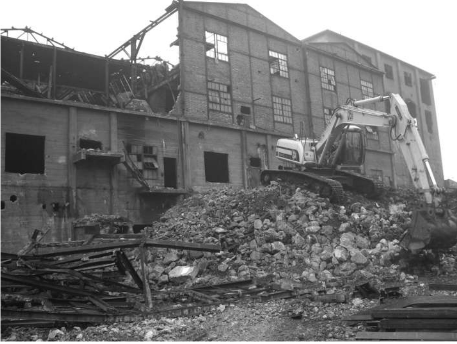
Şekil 3 yıkım sırasında lavuar
