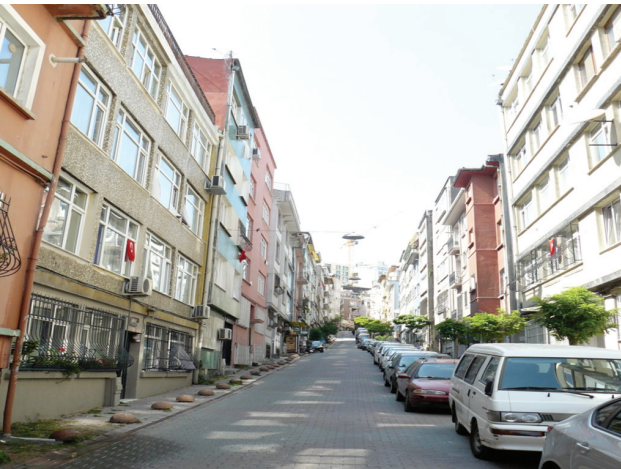
Şekil 2. İstanbul, Cihangir Mahallesi.
