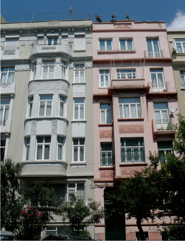
Şekil 1. İstanbul, Cihangir Mahallesi.
