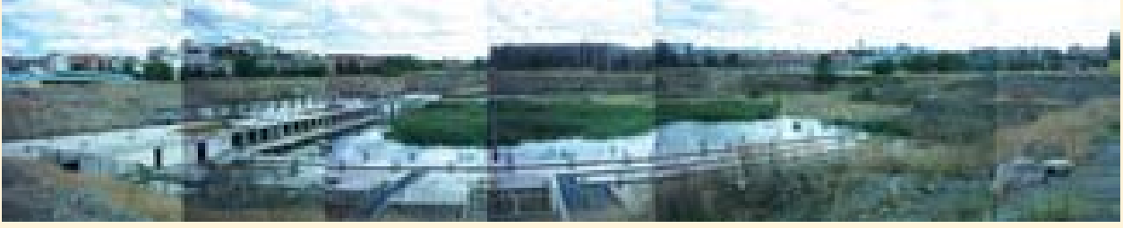
Fotoğraf 4: Yeni CSO Konser Salonu ve Koro Binaları inşaat alanı
