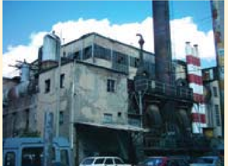
Fotoğraf 3: Elektrik santrali
