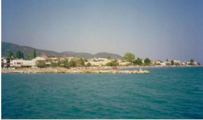
Resim 3: 30 Evler Yapı Dizisi
