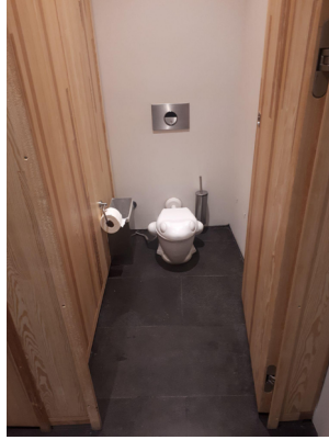
Şekil 2: Odunpazarı Modern Müze’si kadınlar tuvaleti içerisindeki çocuk klozeti.(Şeyma Sarıbekiroğlu, 08.09.2021)
