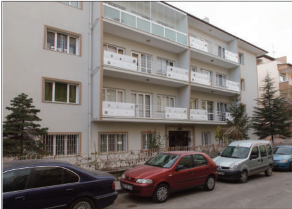
Resim 23. Bardacık Sokak No: 102
