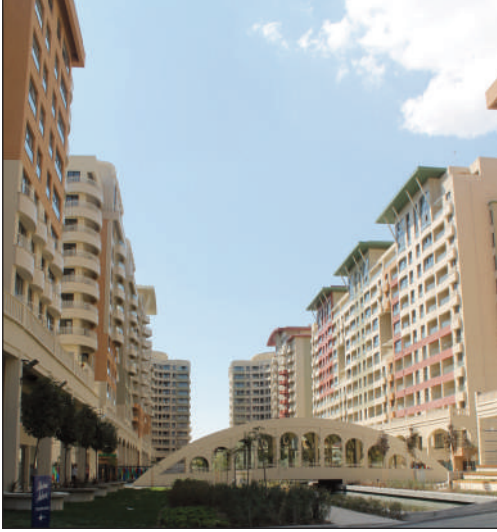
Görsel 4. Yeni Konut Alanı İnşaatlarından 1 (Kaynak: yazar, 2015)
