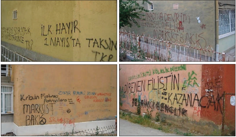
5 Katlı Blok cephelerinden örnekler
