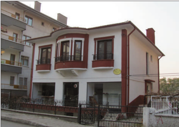
Resim 33. Doğanbahçesi Sokak No: 9
