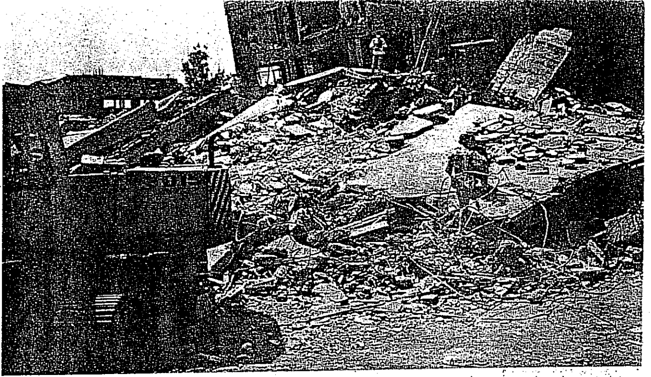
Adapazarı deprem sonrası görünüm (Ç. Kaskınok kişisel belgeliği)
