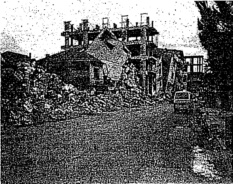
Adapazarı deprem sonrası görünüm (Ç. Keskinok kişisel belgeligi)
