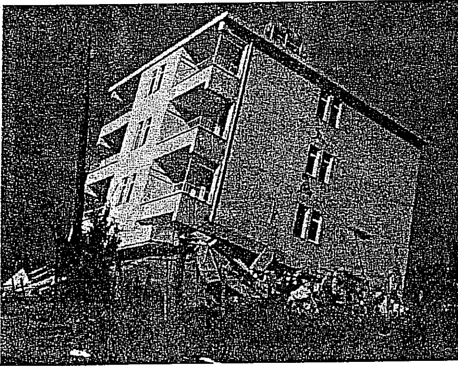
Yapı artık 5 katlı değil.
