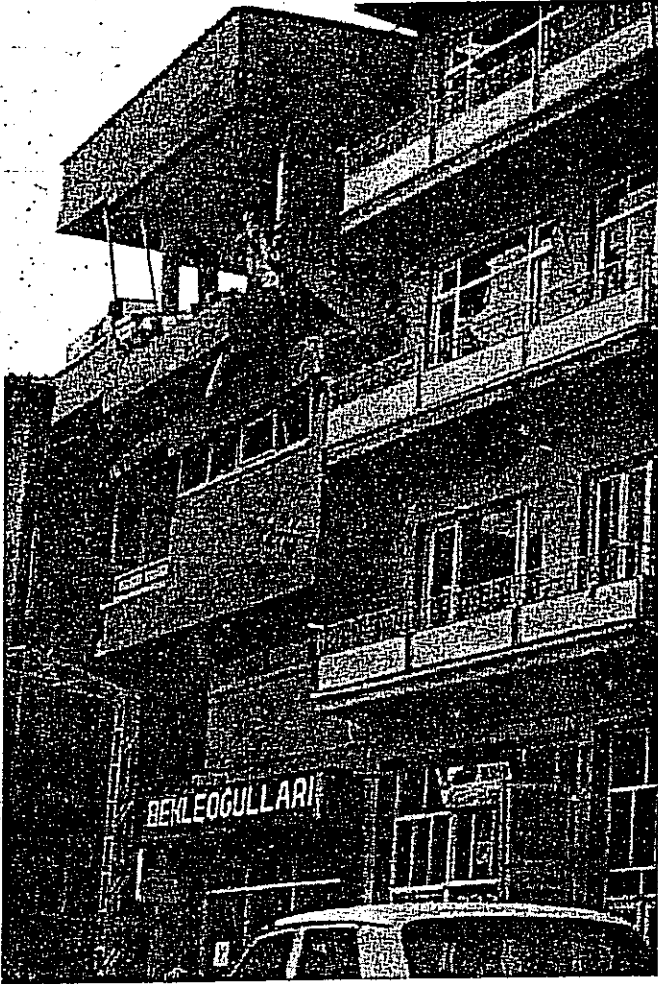
Dinar'da bilmiş düzen, çıkmalı, asimetrik tasarımı ve sonradan kat ilaveî bir yapının depremle aldığı görüntü.
